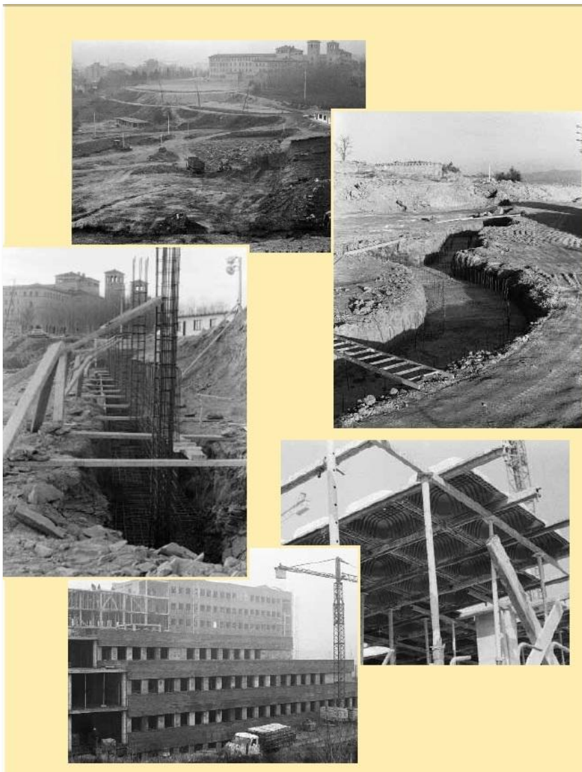
Procés construcció HGV
