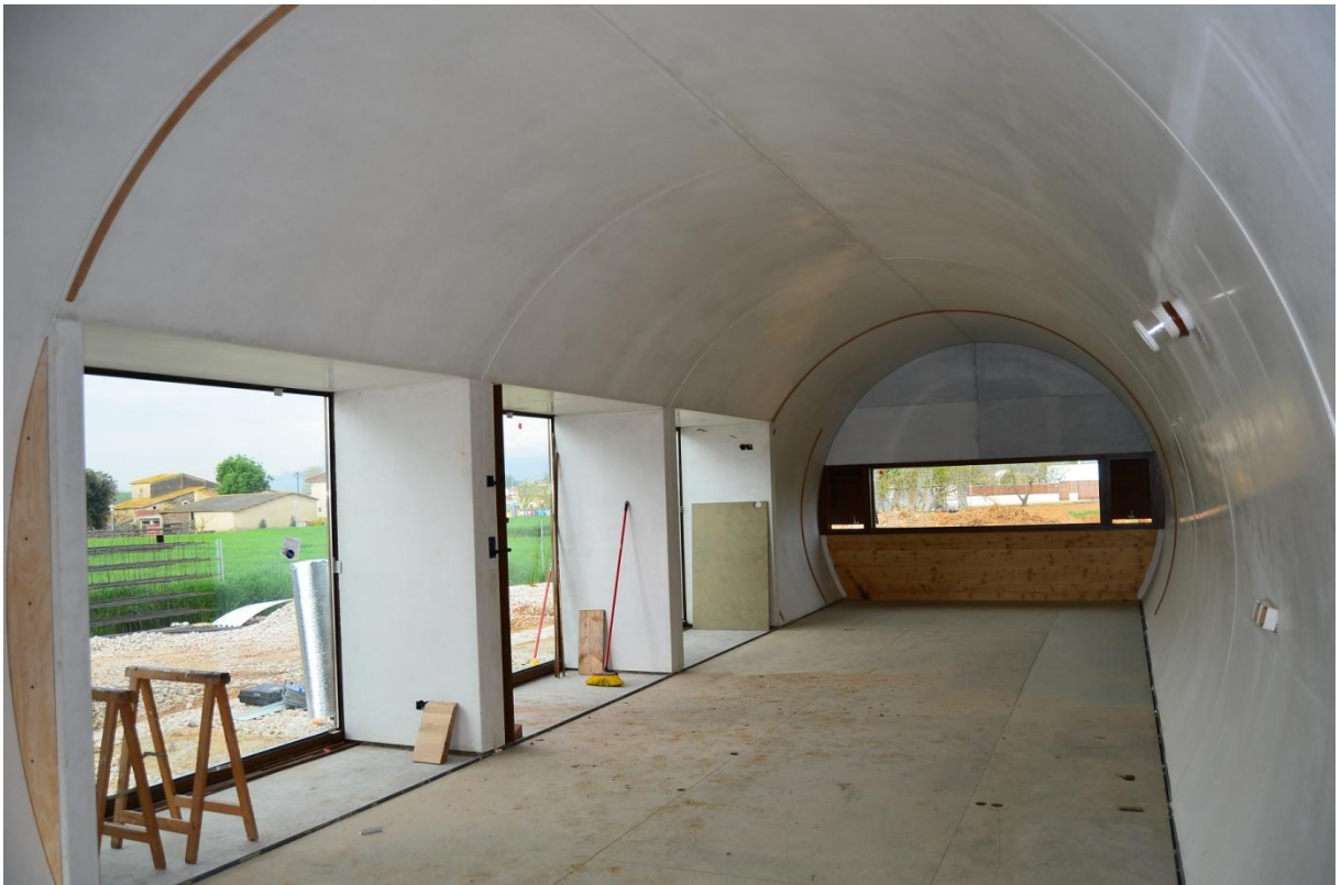
Foto.3: Casa a240 de dins quan estava en construcció.
