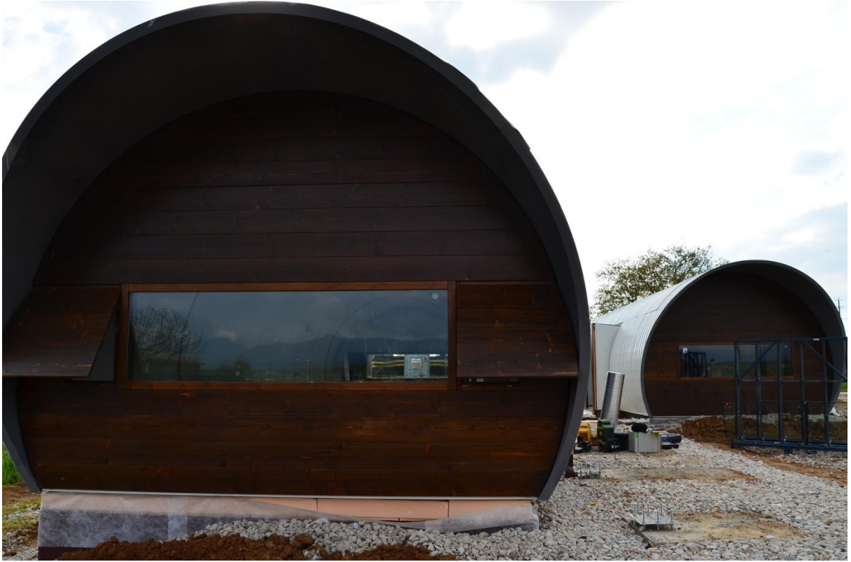
Foto.4: Casa a240 en construcció.
