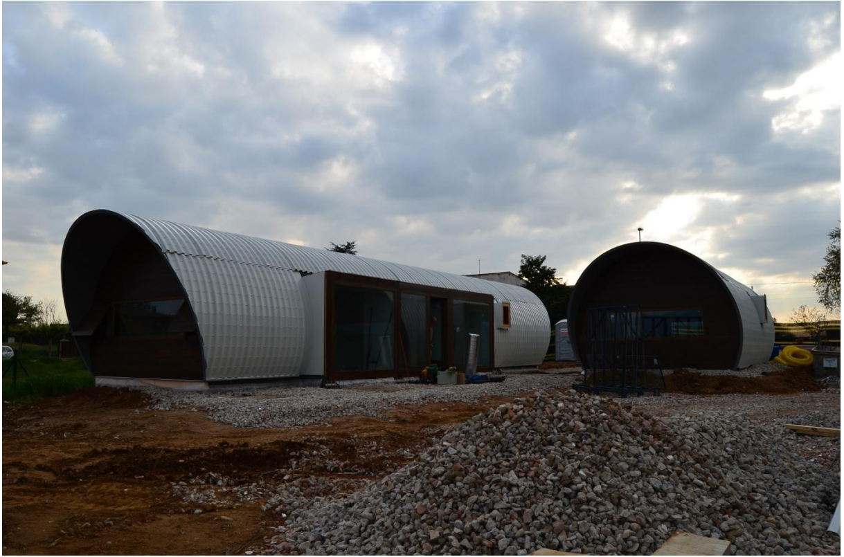
Foto.2: Casa a240 en construcció.
