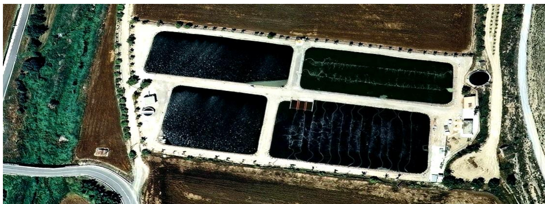
Imatge 2. Estació Depuradora d'aigües Residuals (EDAR) de Cervera i, a l'esquerra, riu d'Ondara. [Ref. 2.4]
