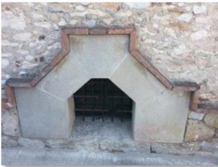
10. Obertures de ventilació, hexagonals i situades a ras de terra. En l'interior, s'alineen amb els revoltos per crear circuits d'aire per sota les tines.
