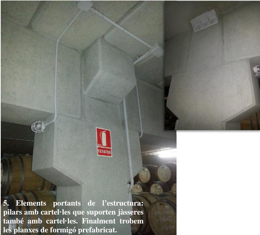
6. Les jàsseres recorren transversalment el celler. Com els pilars, també tenen cartel·la.
