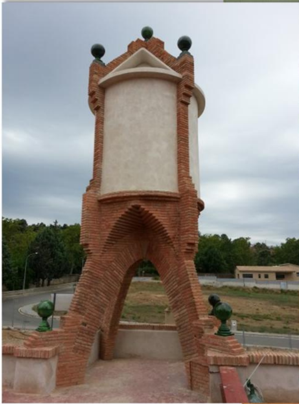
6. Dipòsit d'aigua del celler. Se situa sobre la terrassa posterior i s'alça sobre un encreuament de 2 arcs parabòlics d'obra vista. Queda emmarcat per unes nervadures del mateix material i decorat amb elements esfèrics de ceràmica vidriada verda.
