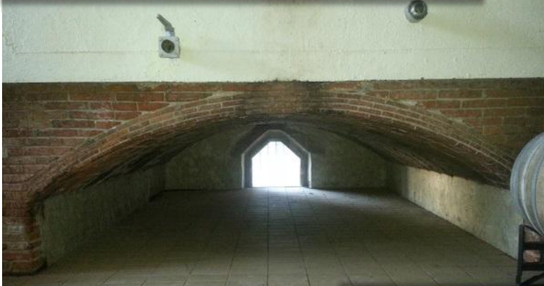
5. Volta a la catalana sobre la qual es recolza la primera tina quadrangular. Al fons, una obertura de ventilació.
