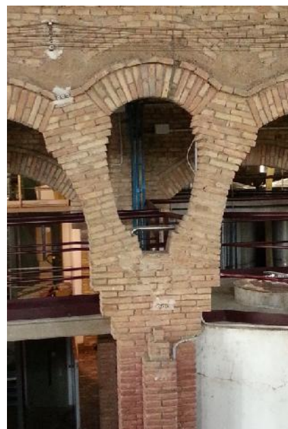
4. Pòrtics d'arcs atirantats que recorren longitudinalment la nau. Són fets d'obra vista i conformen l'estructura portant vertical més important de l'edifici.
