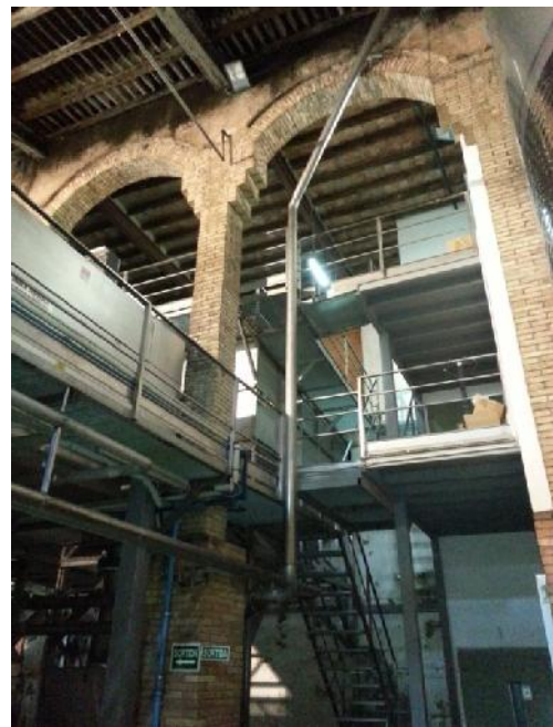
2. Moll de recepció del raïm i sala de màquines. Es troben una a continuació de l'altre i es separen per mitjà d'un pòrtic d'arcs d'obra vista.
