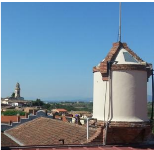
3. Dipòsit d'aigua, situat al mur divisor i entre la doble nau i la sala de màquines. Es recolza sobre un peu de maó i té forma circular.
