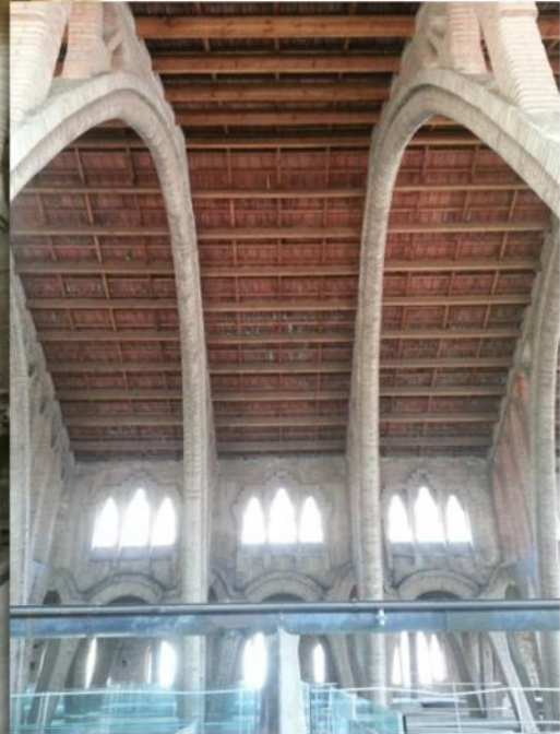
3. Arrencada dels arcs parabòlics de totxo aplantillat, de perfil arrodonit.
