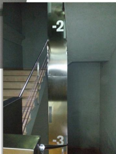
7. La caixa d'escales es situa en el lateral esquerre del celler. En tot moment, informa del pis en el qual et trobes mitjançant un panell lluminós d'acer inoxidable que la recorre verticalment.
