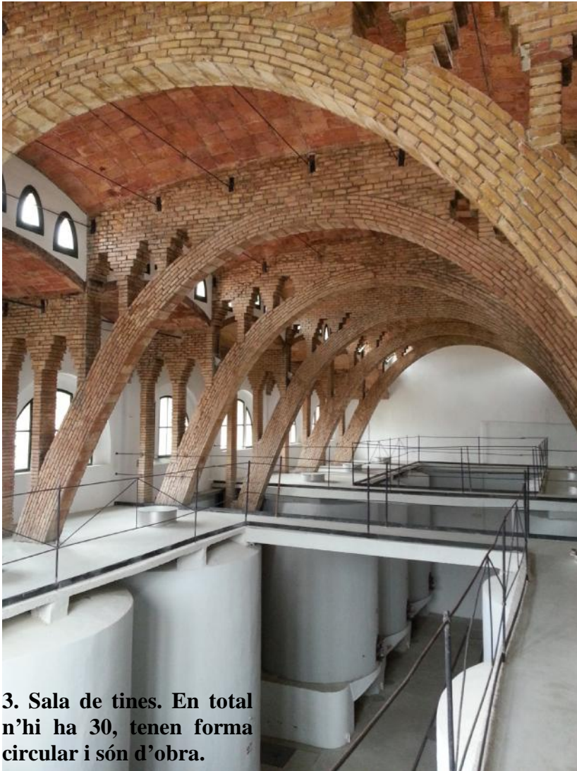
4. L'estructura està formada per arcs parabòlics i carcanyols calats que a mesura que s'afegeixen a la directriu de l'arc, incorporen una filada més de totxo.
