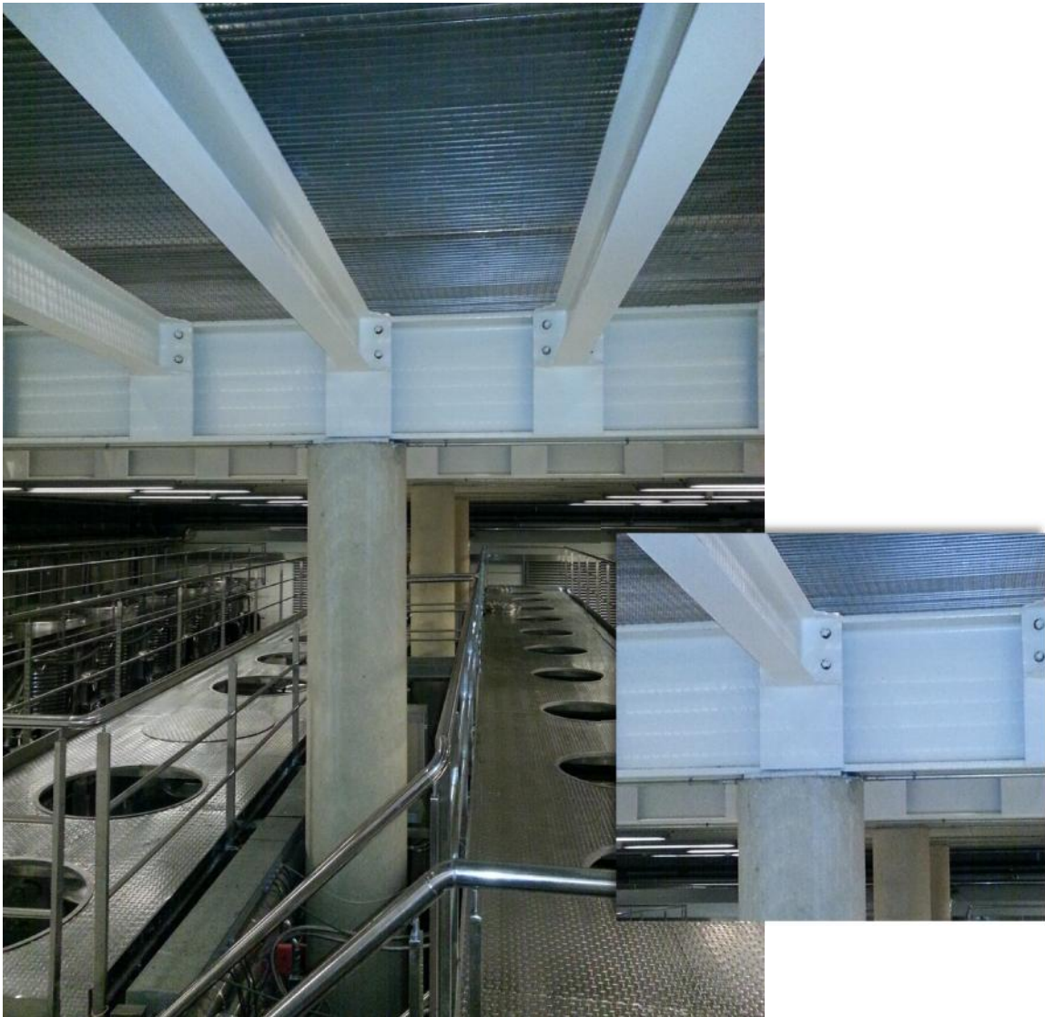
10. El moll de recepció del raïm i la sala de tines, combinen 2 materials en les estructures: el formigó armat en els pilars i el metall en les jàsseres i bigues del forjat.
