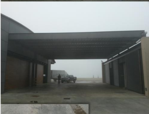
3. Moll de recepció del raïm. S'obre a l'exterior mitjançant una gran porta corredora de fusta de roure. En el paviment exterior, s'obren forats circulars que comuniquen directament amb les tines inferiors.
