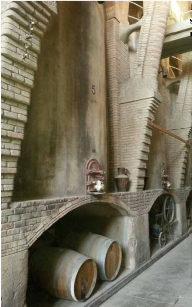
3. Arrencada dels arcs parabòlics de totxo aplantillat, de perfil arrodonit.
