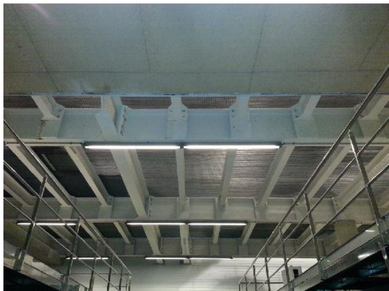
10. El moll de recepció del raïm i la sala de tines, combinen 2 materials en les estructures: el formigó armat en els pilars i el metall en les jàsseres i bigues del forjat.
