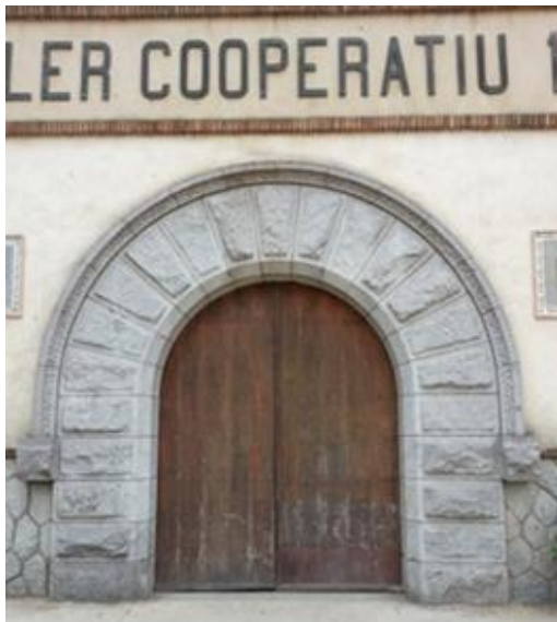
13. Entrada principal, formada per una porta adovellada amb forma d'arc de mig punt, resseguida per un conjunt de peces tallades de granit.
