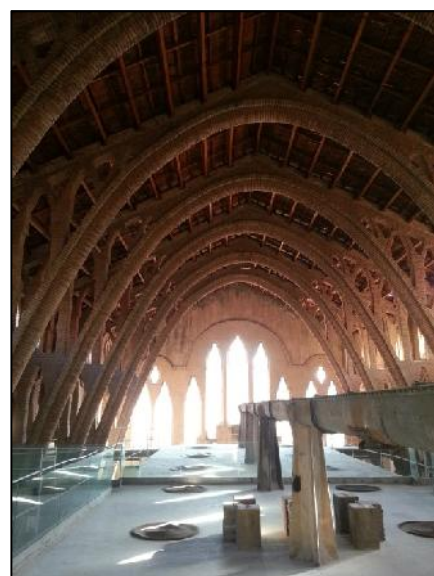
Arcs parabòlics de l'interior del celler del Pinell de Brai. / Font: Pròpia
