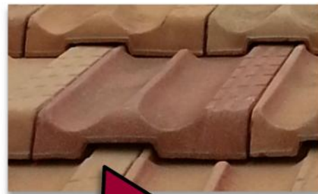
11. Coberta del celler, formada per teules franceses. Entre elles s'hi observen les petites ranures per les quals es produeix el procés de la ventilació.
