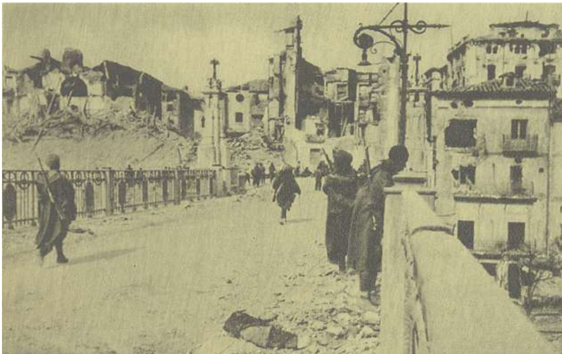
Ruïnes al Viaducte de Terol després de l'ofensiva.
