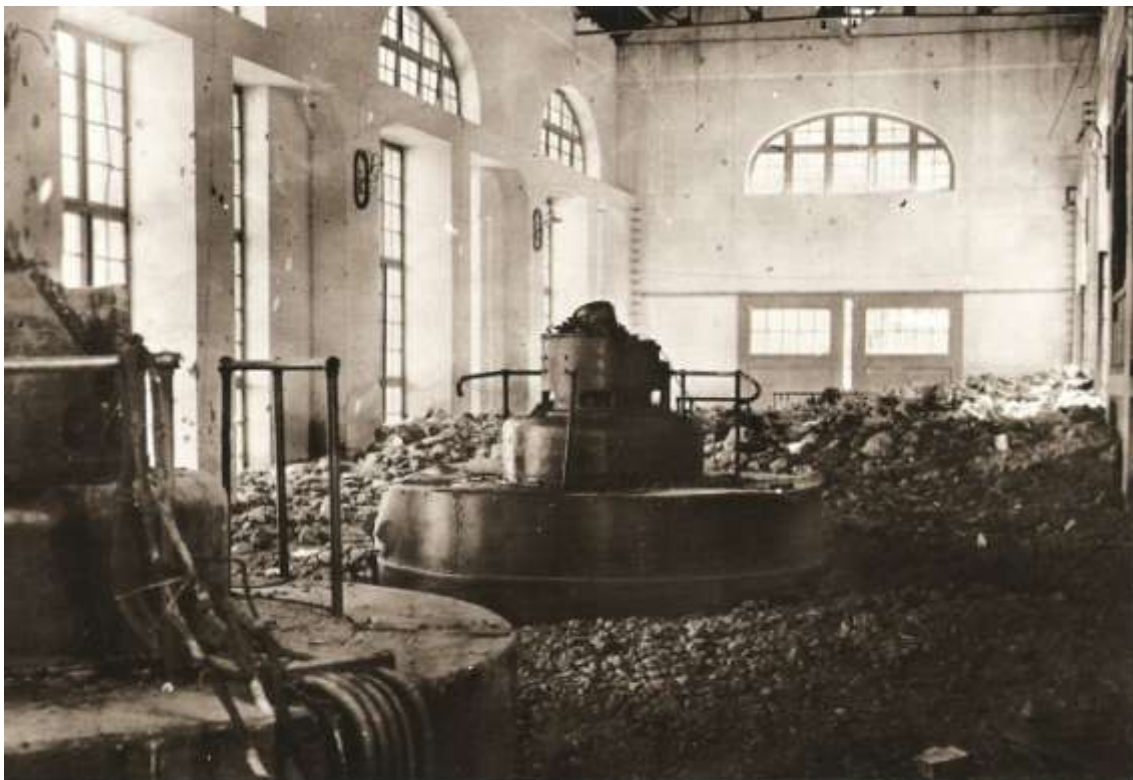
Central de Lafortunada després de la voladura.
