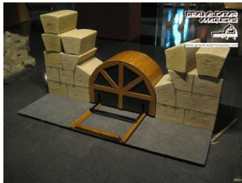
Construcció de brancals i contraforts.
