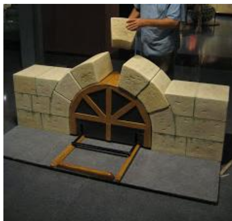
Col·locació de dovelles
