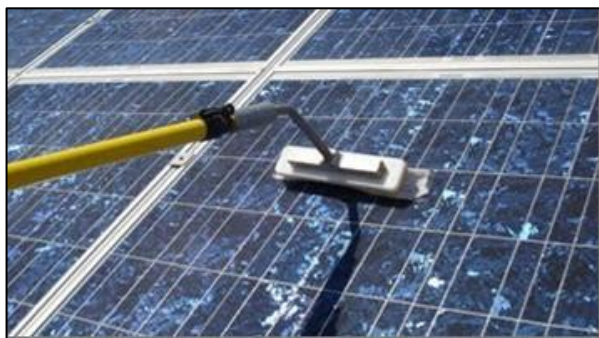
Il·lustració 22. Imatge on es representa el procediment de neteja dels mòduls fotovoltaics.
