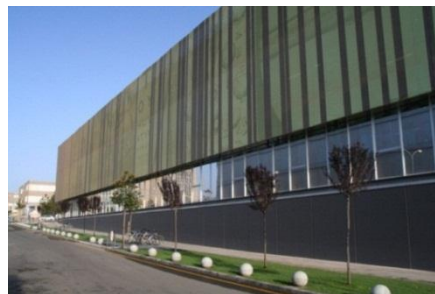
Fig. 29 Façana de l'edifici Hèlix del Parc Científic de Barcelona, on es troba el laboratori Leitat.
