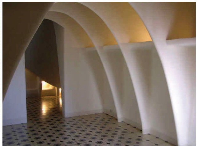
Corbes catenàries a la Casa Batlló
