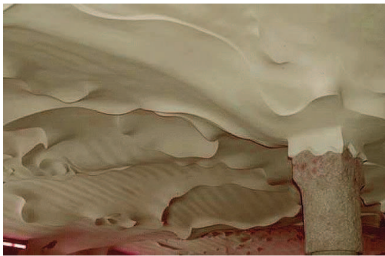
Detall sostre: moviment d'onades
