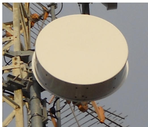
Antena de radio-enllaç terrestre
