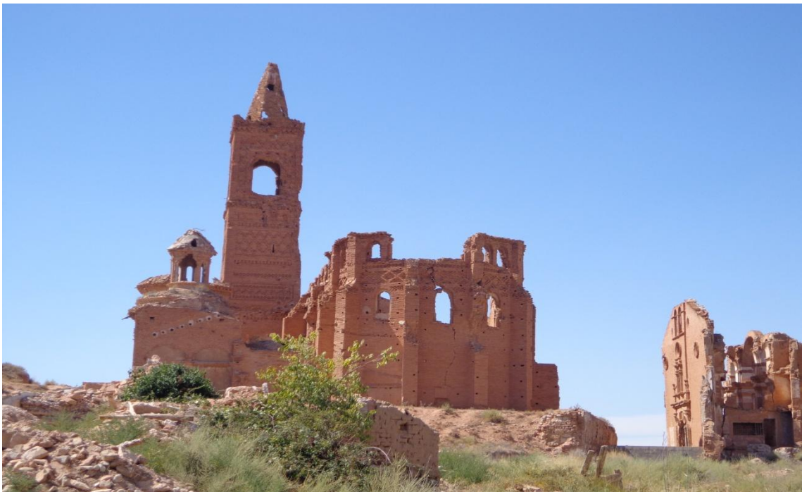
Iglesia de Belchite, junto a convento de San Rafael
