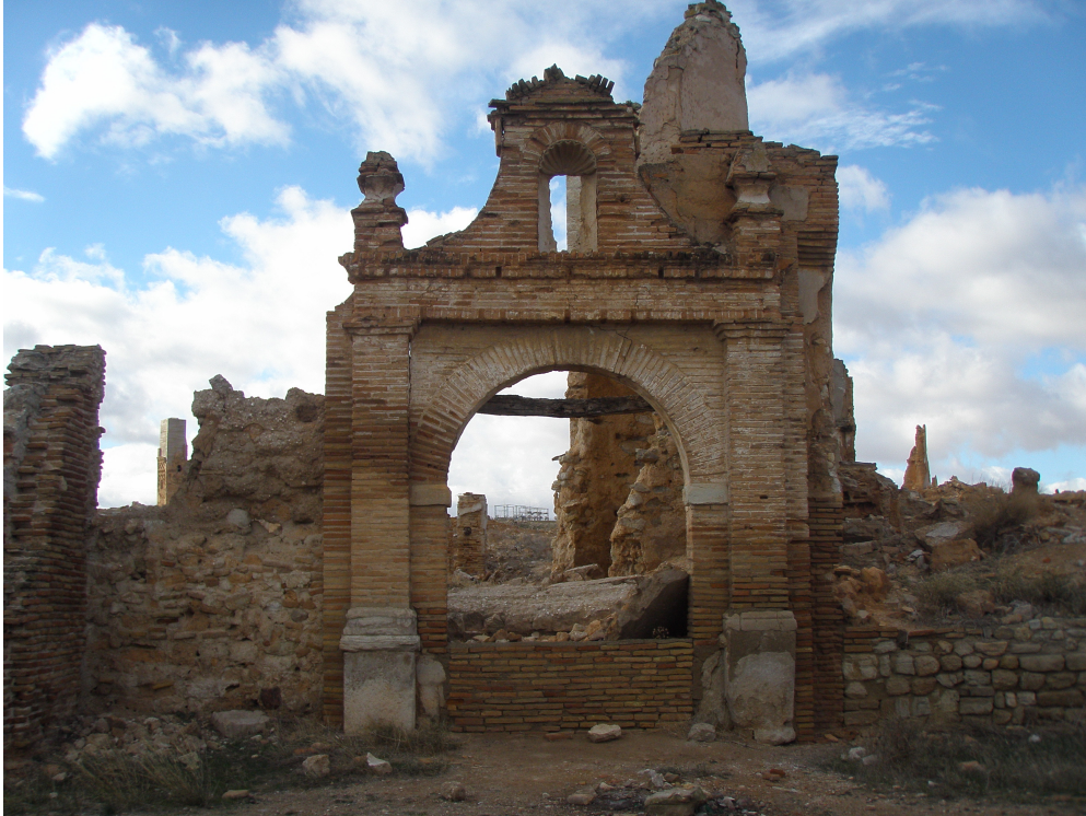
Foto 47: Fachada del ayuntamiento
