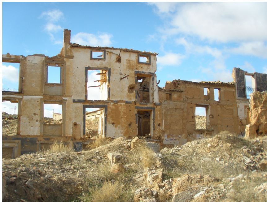
Foto 34: Fachada de las casas del pueblo
