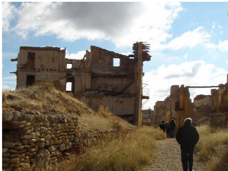
Foto 41: Calle de Belchite. Al fondo el centro del pueblo
