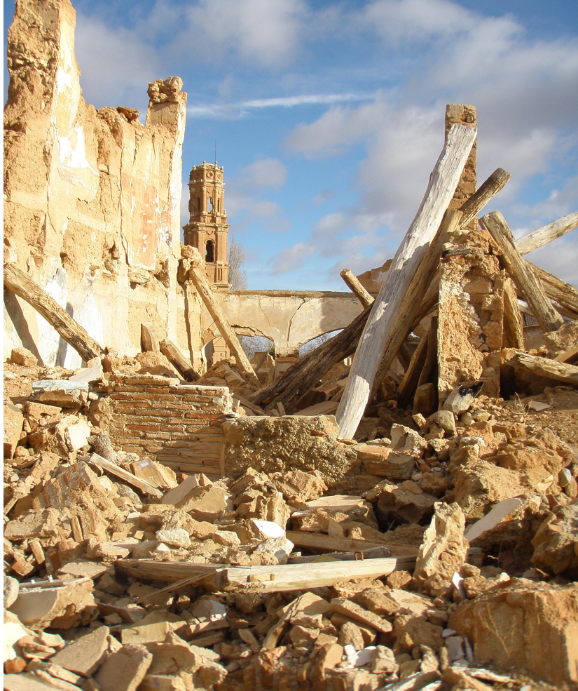
Foto 38: Escombros del interior de una casa
