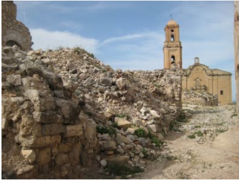
Foto 62: Calle del pueblo. Al fondo la iglesia de San Pere
