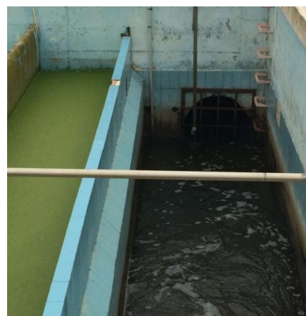
(11) Canal de sortida de l'EDAR cap a l'emissari submarí de Castell.
