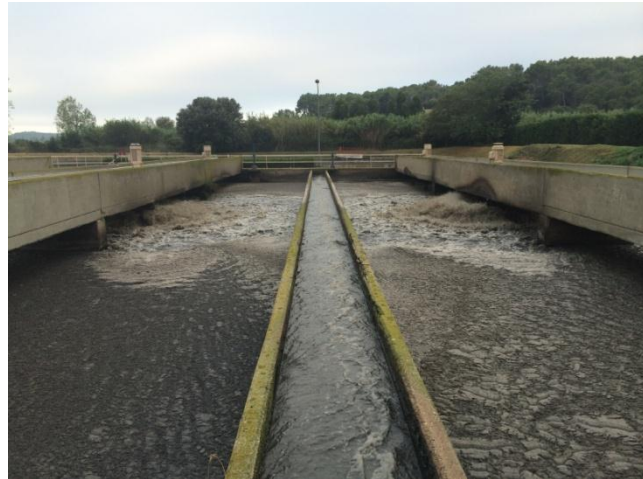
(9) Reactor biològic i canal de recirculació.
