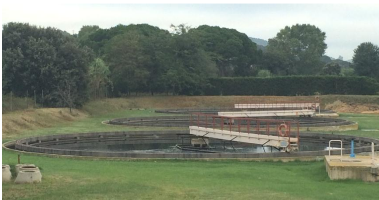
(6) Decantadors primaris. Tractament primari.
