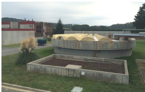
(7) Espesidor primari. Línia de fangs.
