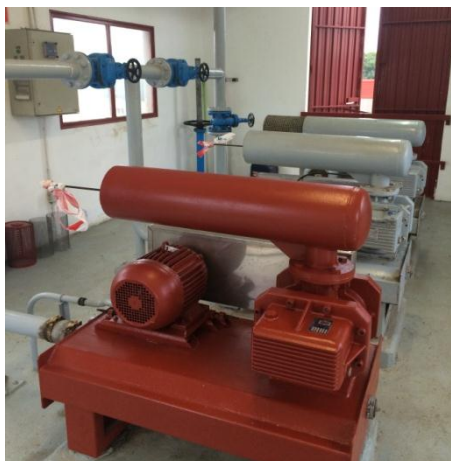
(3) Edifici de bufadors. Pretractament.
