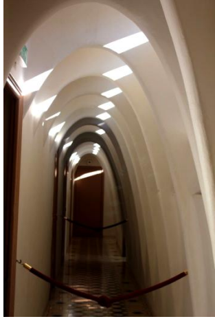
Arcs parabòlics de les golfes de la casa Batlló.
