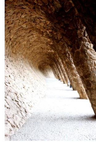
Columnes inclinades situades al Parc Güell
