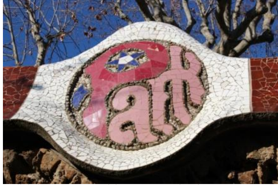
Detall de la part superior del mur que envolta el parc.
