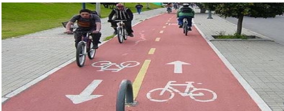
Imatge 22: Carril bici pavimentat de formigó porós
