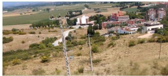
Imatge 25: Torres de les línies elèctriques.
