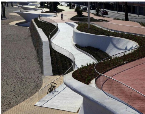
Imatge 10: Rampa d'accés a la platja.
