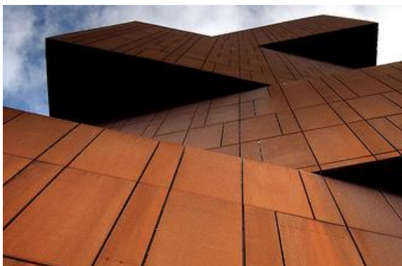
Imatge 26: Edifici cobert d'acer Corten.
