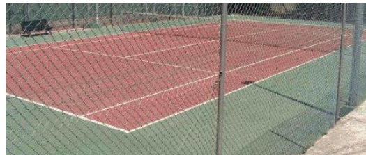
Imatge 23: Pista de tennis pavimentada de formigó porós
