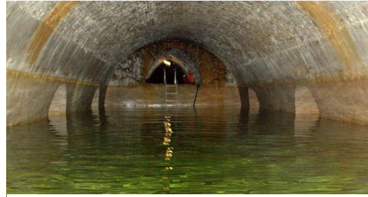
Imatge 19. Cisterna principal
