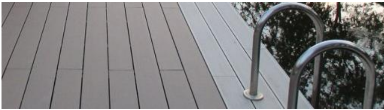
Imatge 28: Paviment de tarima sintètica al voltant d'una piscina.
