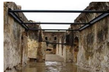
Imatge 12. Interior de l'Hospital.
