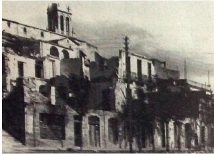
Il·lustració 7: L'hotel Trias completament destruït
