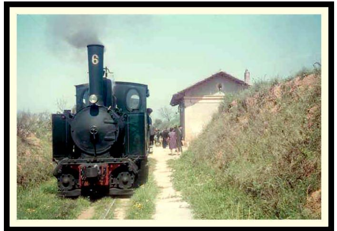
Fotografia 7: El tren a l'estació de Quart
