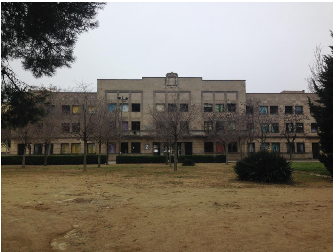
SITUACIÓ ACTUAL DEL FUTUR HOTEL, VISTA ANTIC FAÇANA PRINCIPAL
