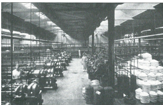
Interior Fàbrica de Cal Gat (1927)
