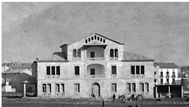
Antic edifici de l'hospital de Campdevàrol.
