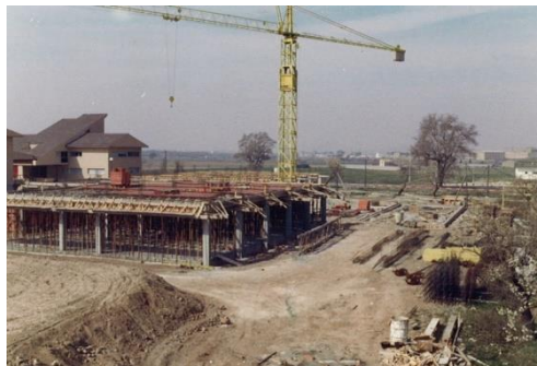
Construcció de l'Ins Alfons Costafreda.
