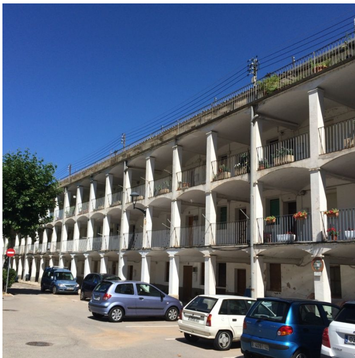
Pisos en galeria a El Guixaró (Casserres)
