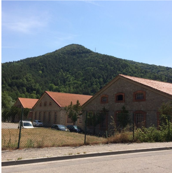
Fàbrica de naus de la colònia Agafallops (Ripoll). Es distingeix que és de naus ja que té varis edificis paral·lels de poca alçada
