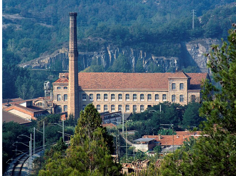
Fàbrica de Borgonyà. L'espai productiu combina les naus, situades a l'esquerre de tot de la imatge, amb la fàbrica de pisos, al centre de la fotografia.
