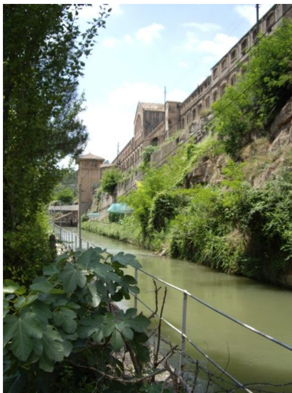
Canal i fàbrica de la colònia Vidal, a Puig-reig
