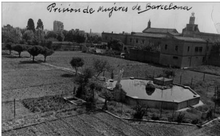
Imatge 15. Panoràmica exterior de la presó de les Corts
