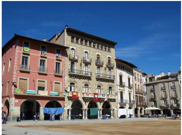
Imatge 9. Cases de la Plaça Major de Vic. Exemple de construcció amb pedra de Folgueroles (casa central).
