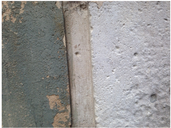
Imatge 8. Capa de pintura sobre un porter de calç (esquerra) i pedra de Sant Bartomeu del Grau (dreta).
