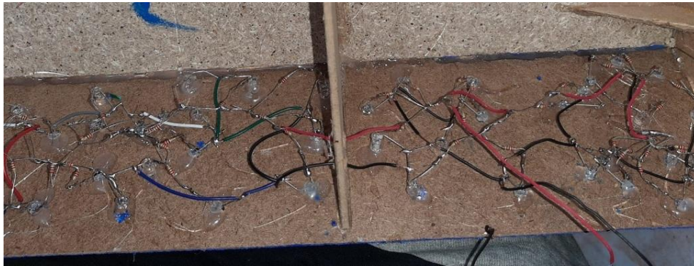
Figura 54. Vista interior del lateral amb instal·lació dels LEDs
