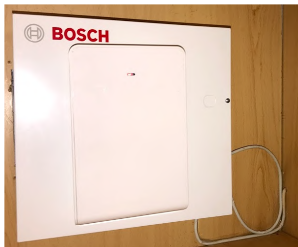
Figura A.9: Resultat final de la caixa de la central BOSCH AMAX 3000 Font: Creació pròpia
