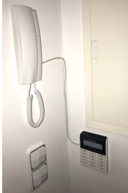
Figura A.10: Resultat final del teclat del sistema d'alarma BOSCH AMAX 3000
