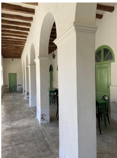
Figura 33: Galeria porticada Font: autora del treball
