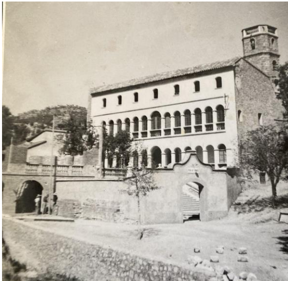
Figura 31: Entrada a La Puda de Francolí Font: Èlia Gabarró Rigolfas
