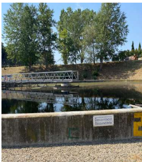
Figura 22: Imatge de la vora del decantador, el creixement d'algues ens indica el seu bon estat (Imatge pròpia).
