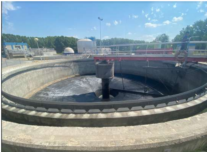
Figura 17: Decantador primari (Imatge pròpia).
