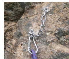
Figura 6. Espit colocado en roca
