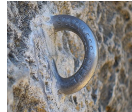
Figura 8. Químico colocado en roca
