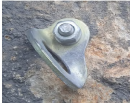
Figura 7. Parabolts colocado en roca. [Fuente propia]
