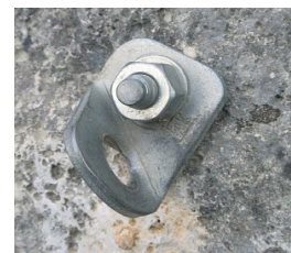
Figura 6. Espit colocado en roca
