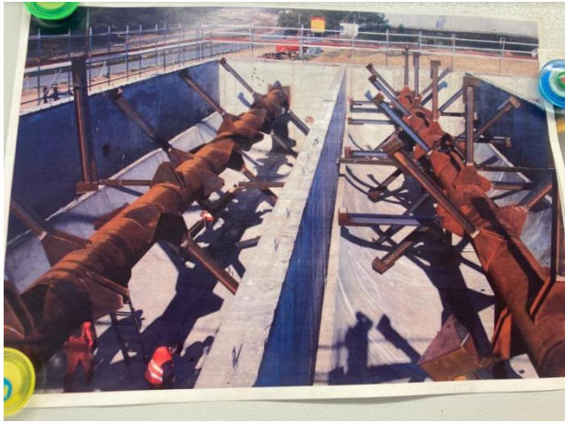
Figura 16: imatge del digestor en construcció.
