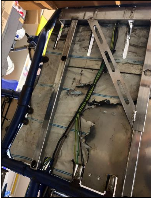
Cables per sota del kart Font: Pròpia
