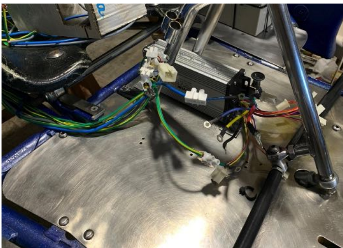
Cables cap al controlador Font: Pròpia
