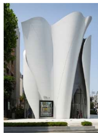
Figura 76. Borel, N & Portzamparc, C. Façana de la botiga Dior, Seul, Corea del Sud; carcassa de fibra de vidre blanca [Fotografia]
