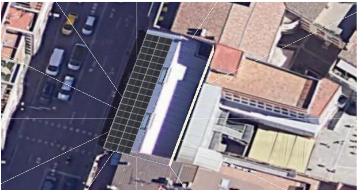
Imatge 27. Plaques solars instal·lades terrat Batxillerat-Primària
