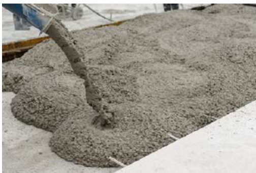
Imatge 5. Formigó en massa
