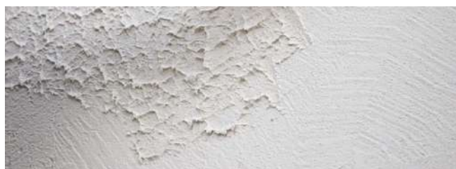
Imatge 12. Revestiment de guix
