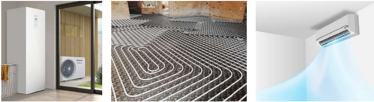
Imatges 57, 58 i 59. Màquines aerotèrmia, terra radiant i aire condicionat
