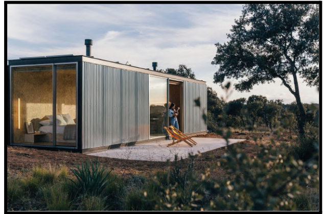
Figura 6. Exterior de la "Tiny House" de Conca. Font: Arquitectura y Diseño. Conca: 16 de maig del 2022.
