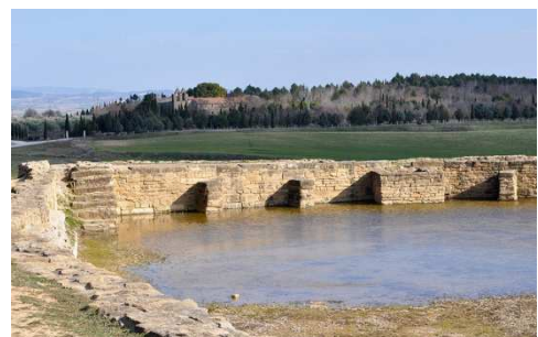
Núm.11 Dipòsit regulador d'Andelos
