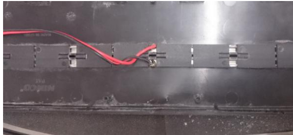
Imatge 1.64: Cable soldat a la pista perquè passi el corrent elèctric
