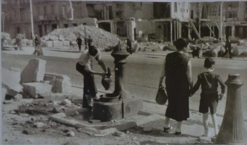
Los bombardeos han destruido numerosos edificios e infraestructuras en casi todas las calles de Barcelona
