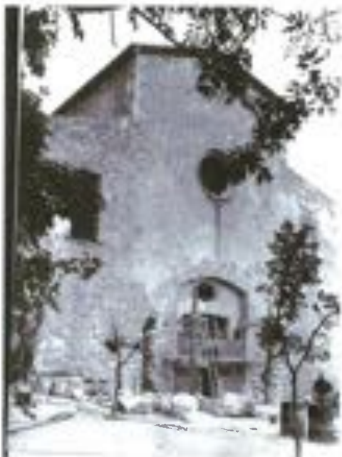
La façana en obres ja sense el campanar i obrint-se l'arcada. . Fotografia arxiu Cortina-Farràs.
