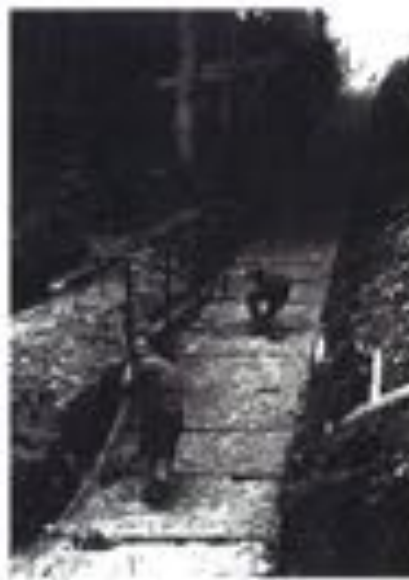
Treballs de construcció. Fotografia R. De Bobes.
