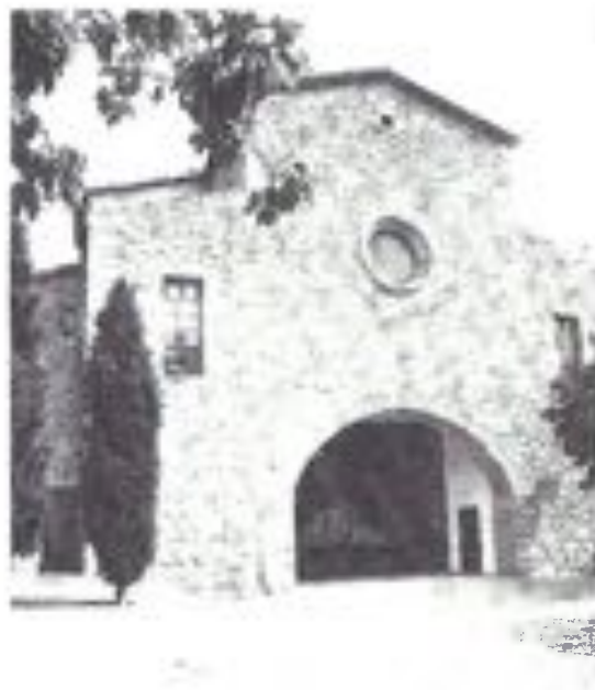
La façana ja finalitzada, amb l'arcada oberta.. Fotografia arxiu Cortina-Farràs.
