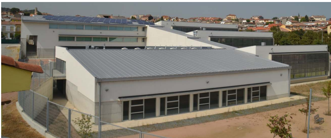
Figura 24. Edifici de l'Institut del Voltreganès
