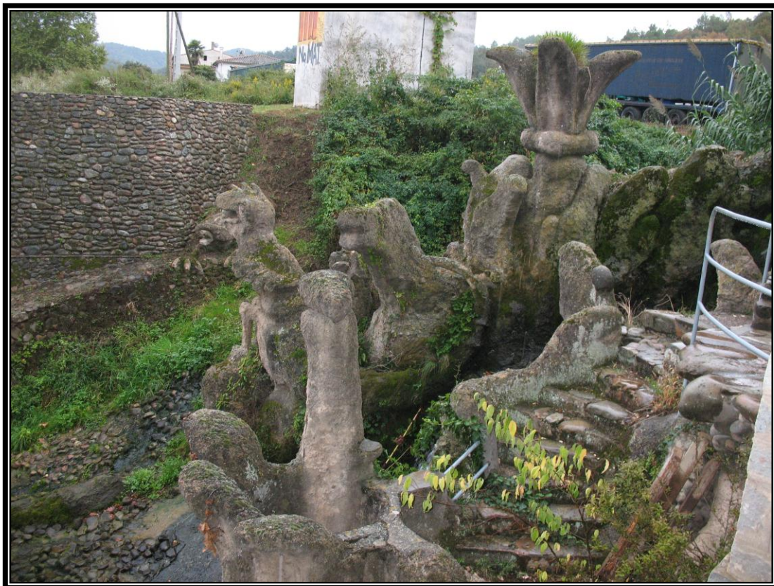
Fotografia realitzada des de la finestra de la sala de turbines. S'hi poden veure els monstres de la central, una vista que devia acompanyar el dia a dia dels treballadors de la central. (Font: Elaboració pròpia)
