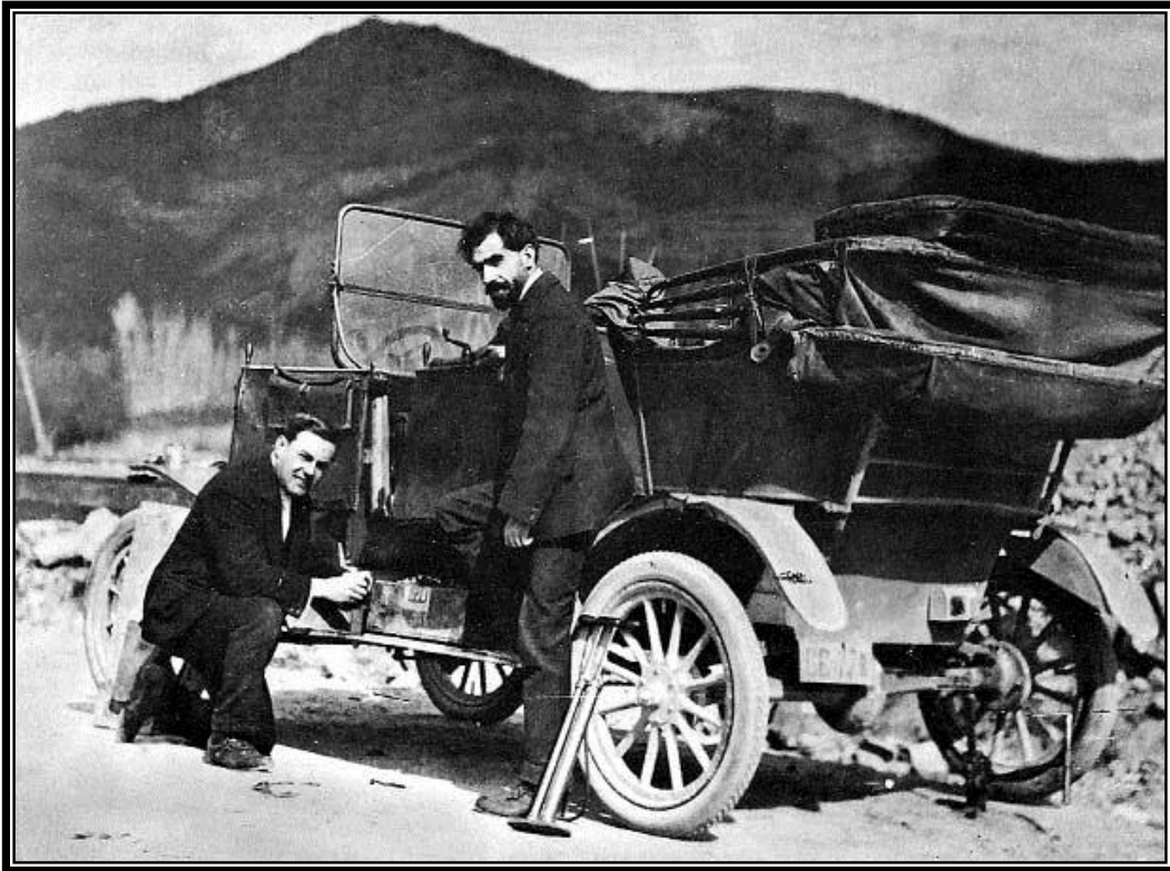
A la imatge, Joan Roca i Pinet, de genolls. Dret, Miquel de Palol 1 . Fotografia presa entre l'any 1915 i 1916, durant el trajecte fins a Bescanó per supervisar les obres de la central del Turó dels Cavalls. (Font: Revista de Girona , n. 248, 2008)
