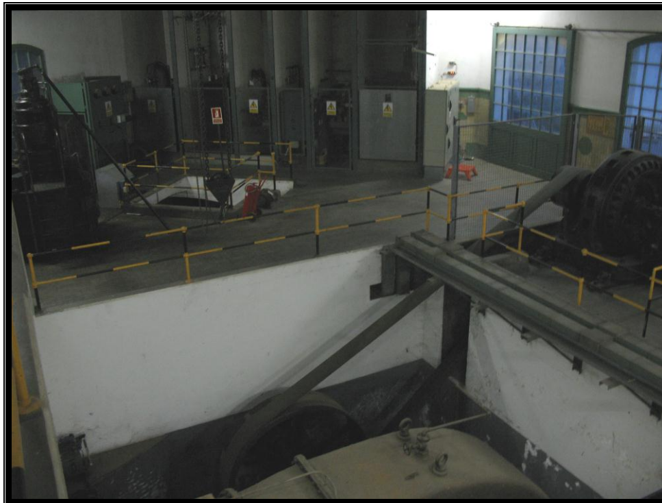
Imatge aèria de la central realitzada des del punt on hi ha la sala i l'ordinador de control. S'hi poden observar 2 de les 3 turbines (L'altre, la 3, està a una sala contigua), un generador, i els transformadors. (Imatges d'elaboració pròpia)
