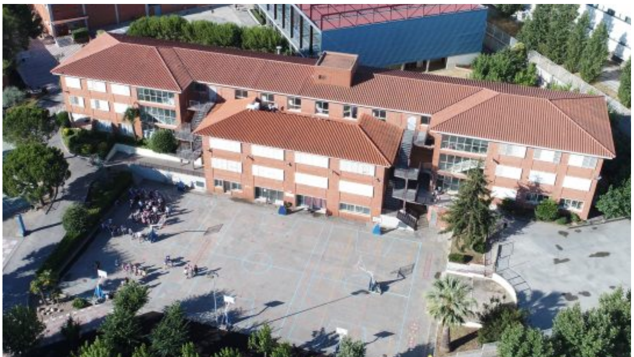
Figura 7: Fotografia des d'una posició elevada de l'edifici A de l'escola.
