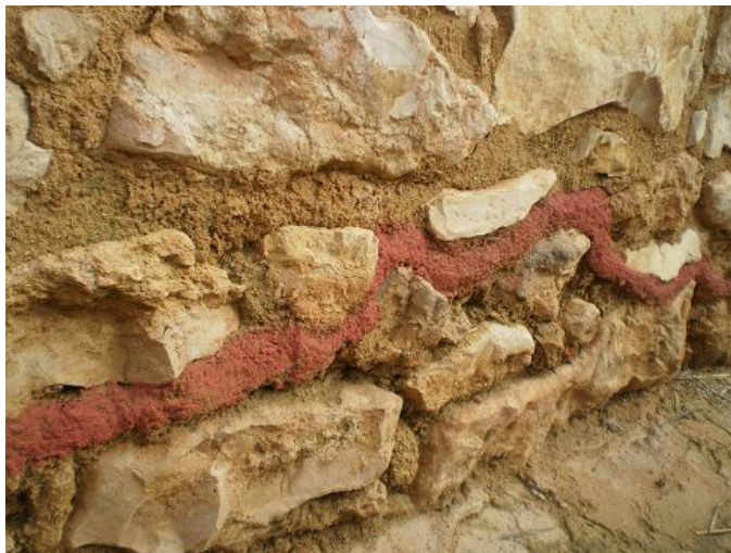
Mur reconstruït de la Ciutadella Ibèrica de Calafell. L'argamassa vermella s'utilitza per a diferenciar la part original de la reconstruïda
