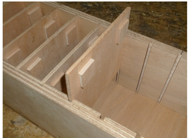
Il·lustració 11: Detall dels encaixos.
