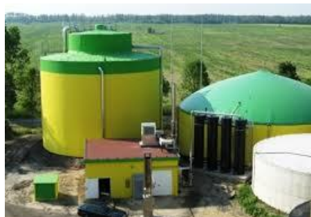
F14. Planta de Biogàs.
