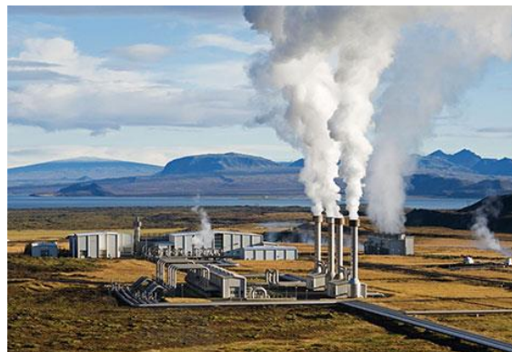
F12. Central geotèrmica.
