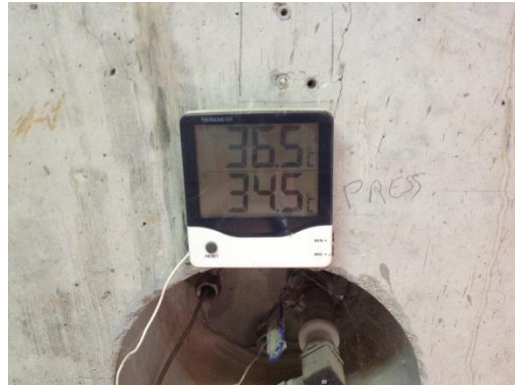
F36. Termòmetre d'un digestor.
