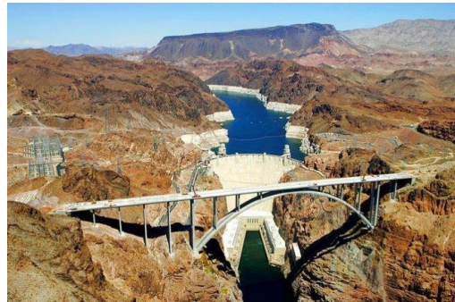
F9. Central hidroelèctrica. (Presa Hoover)
