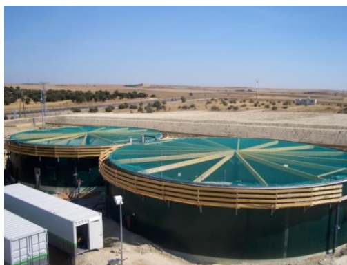
F19. Digestors en construcció d'una planta de biogàs.
