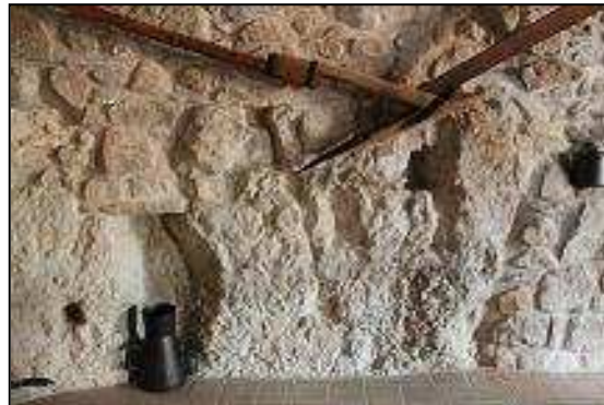
Paret interior de Cal Cintet en què es veuen els fonaments
