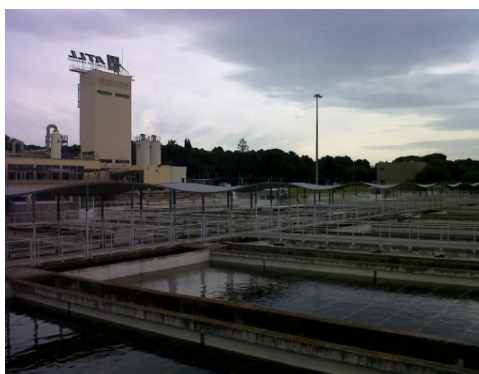
Imatge 1. Vista general de l'ETAP del Ter
