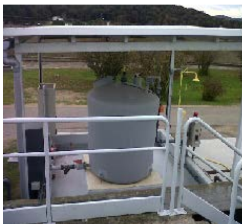
Imatge 3. Cloració amb clor gas després de passar pels filtres de carbó actiu
