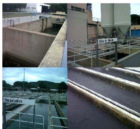
Imatge 2. D'esquerra a dreta. A dalt: obra d'arribada i obra de mescla (adició del coagulant). A baix: decantadors i filtres de carbó actiu
