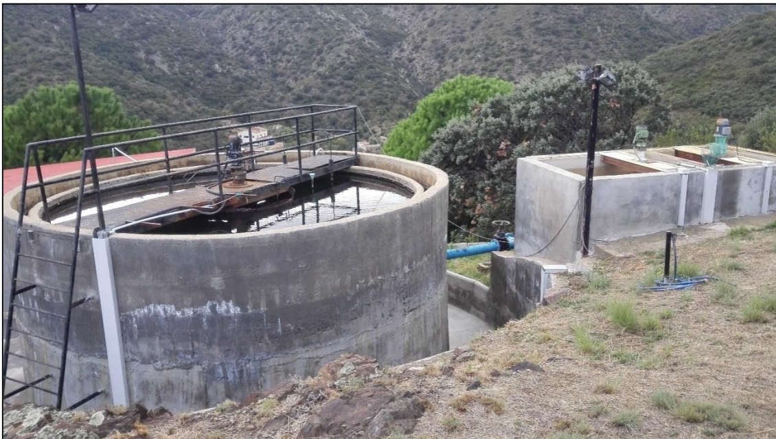
Decantadors de la planta potabilitzadora. Font: Marc Deu
