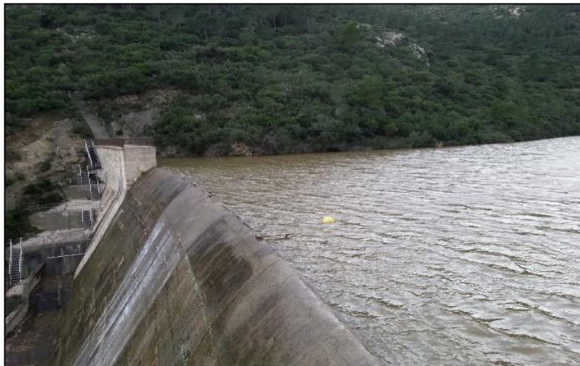
Vista del nivell d'aigua de la presa de Portbou21 de desembre de 2014. Font: Marc Deu
