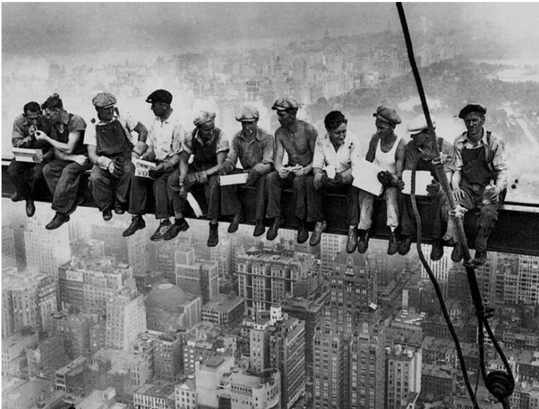
Fotografia de la sèrie de la construcció de l'Empire State. Foto: Lewis Hine.
