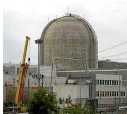
Fig. 4. Central nuclear de Vandellòs (Espanya)
