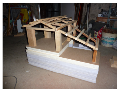
Figura 12. Muntatge de l'estructura 2, (Tragó, 2013). Font: Elaboració pròpia.
