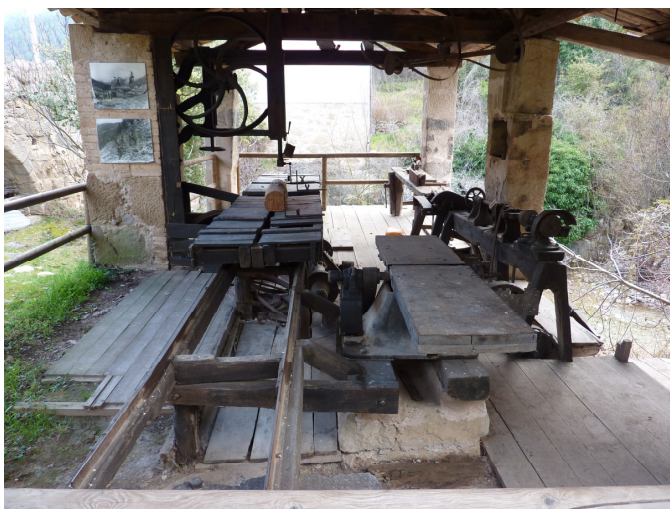
Figura 10. Vista general de la serradora de Ca l'Ambròs, (Navès, 2013). Font: Elaboració pròpia.
